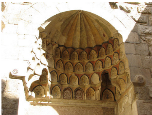
Schmuckelement über einem Durchgang
